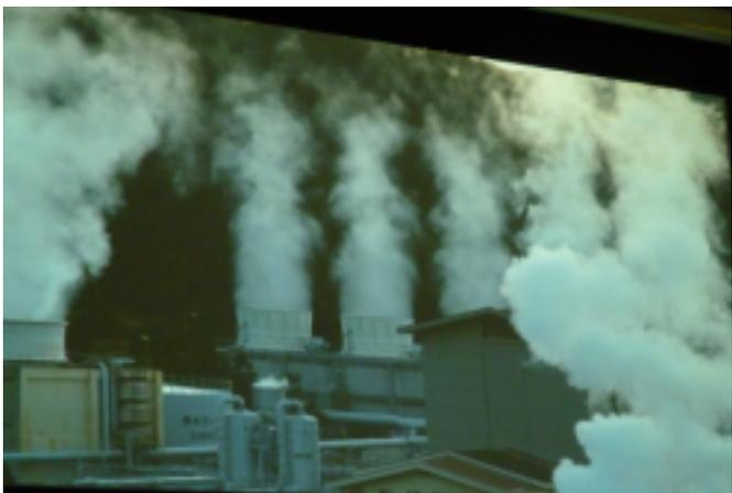
冷却塔からの大量の水蒸気があがる。使用後の蒸気を冷やし冷却水をつくる。(九電ビデオ「大地からの贈り物」より)
