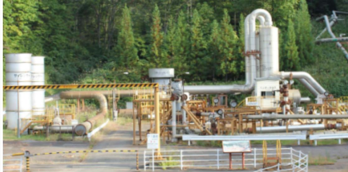
左端がサイレンサー(噴出音の消音)、真ん中奥がフラッシュタンク(還元量を大気放出させ調整する)、右の2基が気水分離器=セパレータ(蒸気と熱水に分離)、その右手前がヘッダータンク(還元量を水位調整)。(出典：「柳津西山地熱発電所への地熱蒸気供給の概要と今後の展望」安達正敏、2011/7/7 ~ 東北大学大学院環境科学研究科 震災フォーラム第2回)
